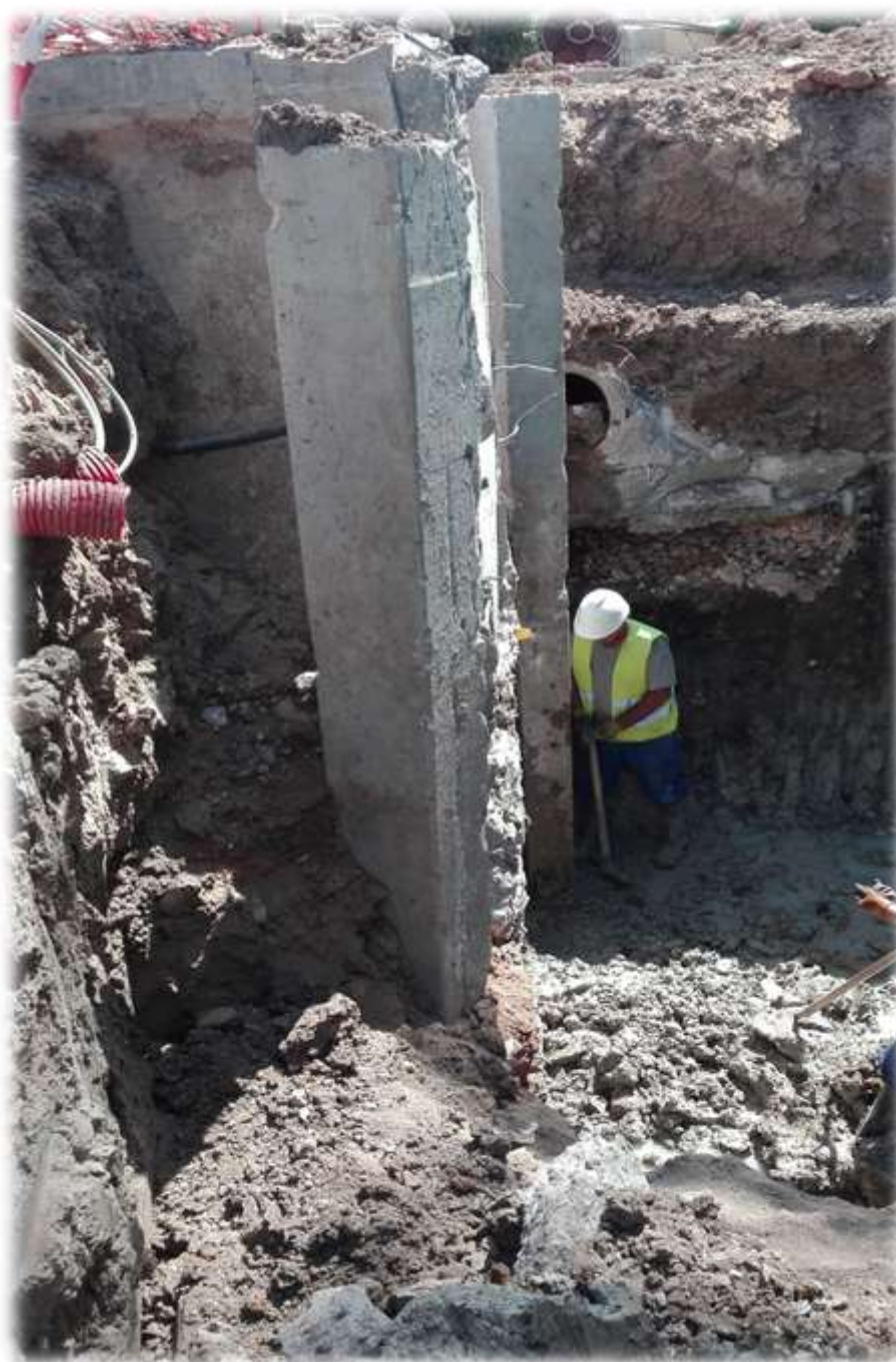
Vaciado y descabezado de pilotes
