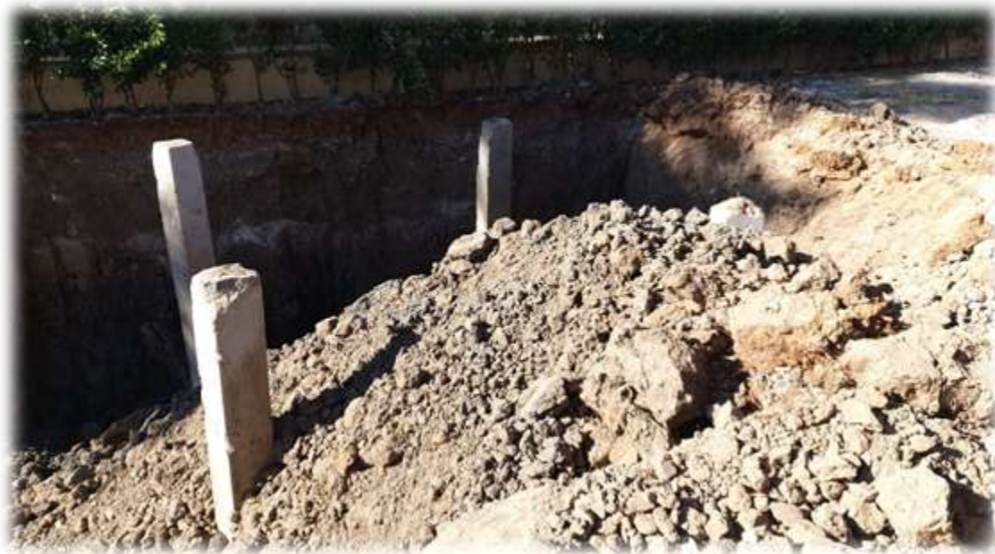
Vaciado y descabezado de pilotes
